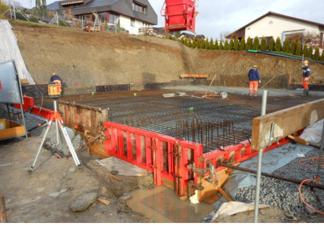
DIE BODENPLATTE WIRD BETONIERT UND DIE INNEREN KELLERWÄNDE GEMAUERT
