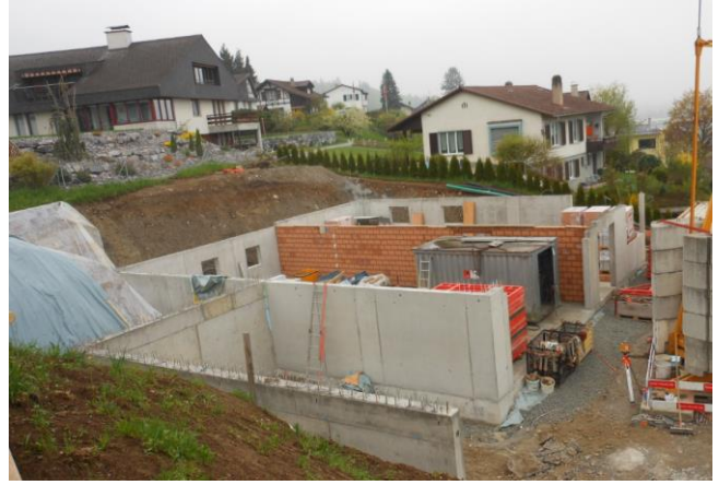
DIE BODENPLATTE WIRD BETONIERT UND DIE INNEREN KELLERWÄNDE GEMAUERT
