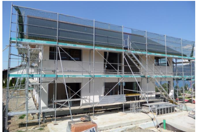
PHOTOVOLTAIKANLAGE AUF DER SÜDSEITE
