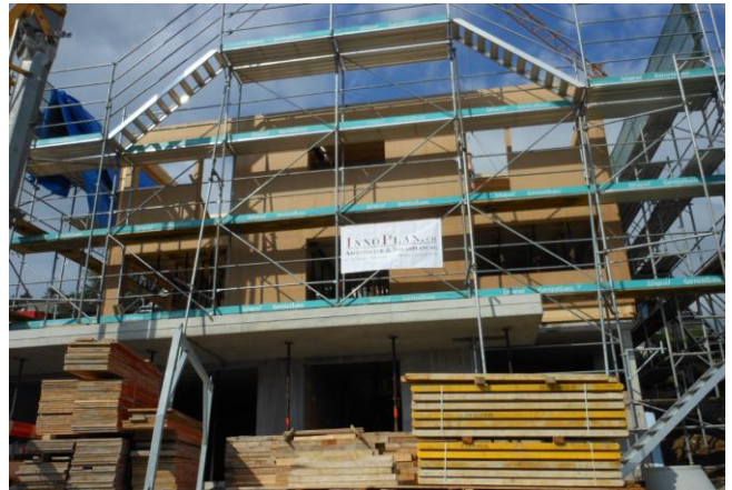
DAS HAUS WIRD AUFGERICHTET
